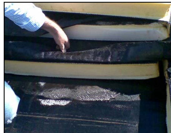
Polistirene espanso estruso T_{\max} 75\text{ }^{\circ}\text{C}
