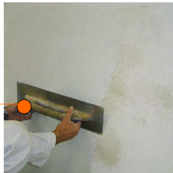
Applicazione della 2° mano di rasante per chiudere le imperfezioni
