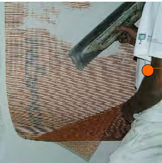
Applicazione della 2° mano di rasante per chiudere le imperfezioni
