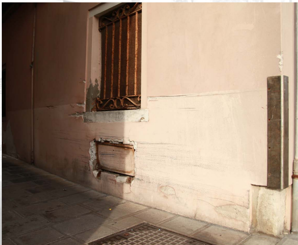
Prospetto di civile abitazione, Chioggia.
