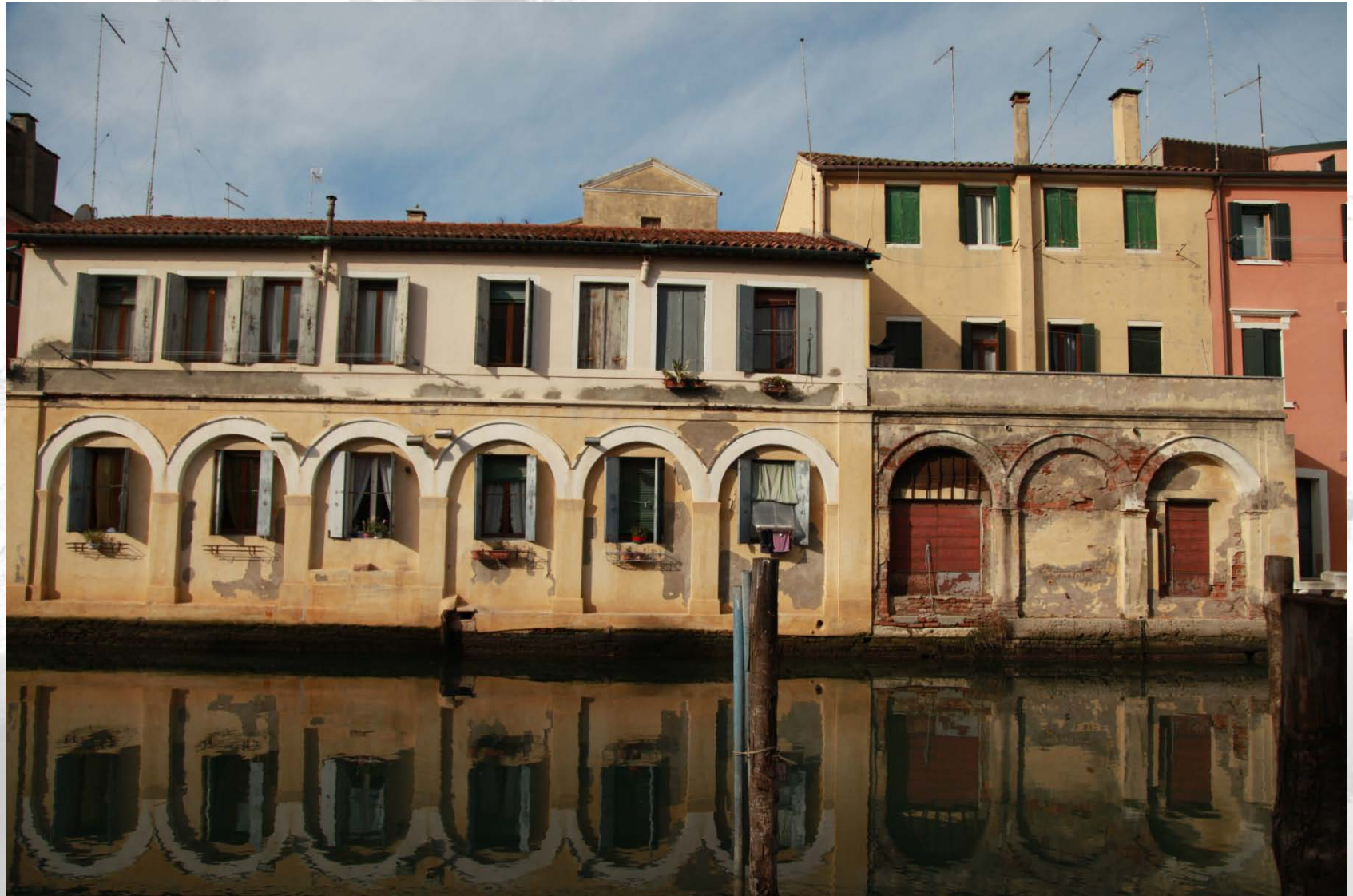
Vista di fabbricati del Canal Vena, Chioggia
