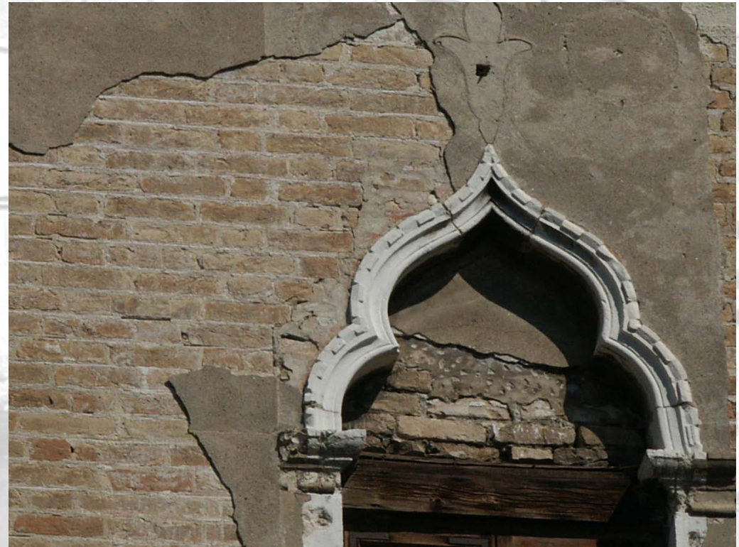
Particolare della facciata di Palazzo Gritti Badoer, Venezia
