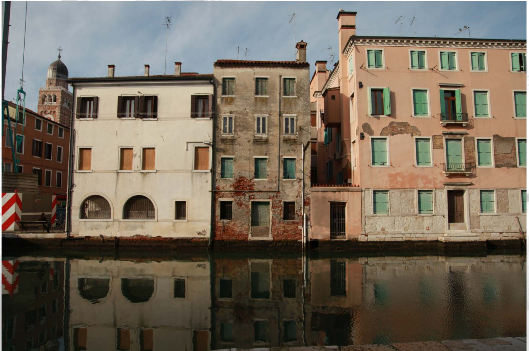
Vista di fabbricati del Canal Vena, Chioggia
