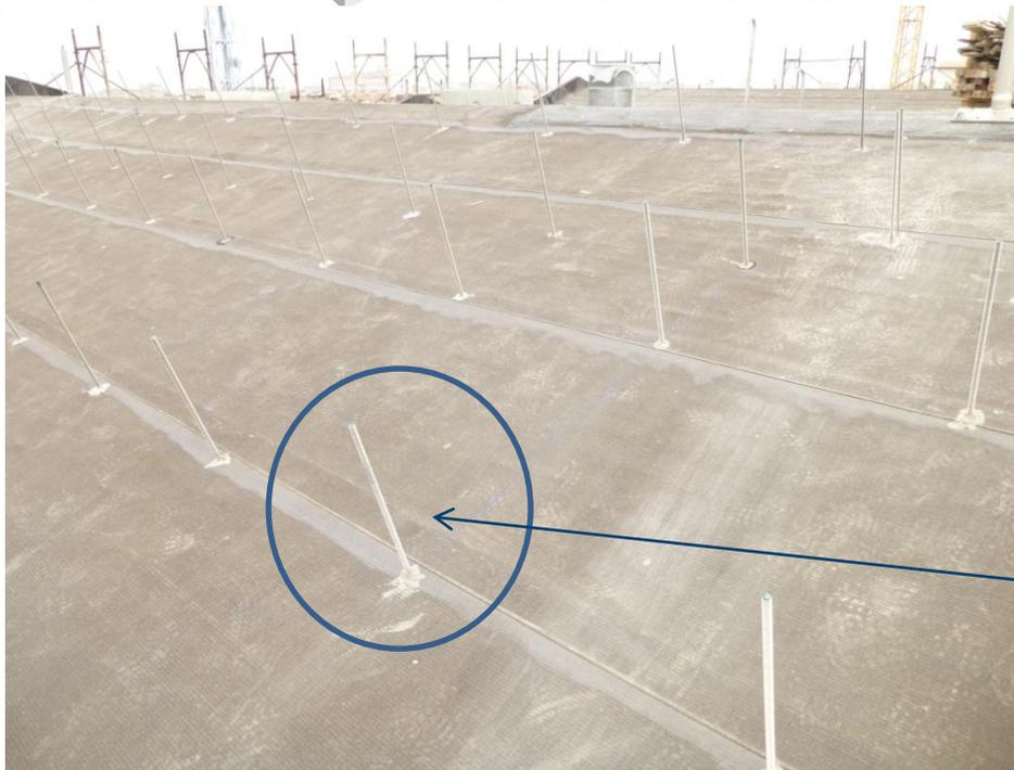
I moduli verranno montati su dei supporti in acciaio zincato aderenti al piano di copertura, tutti con la medesima esposizione.
