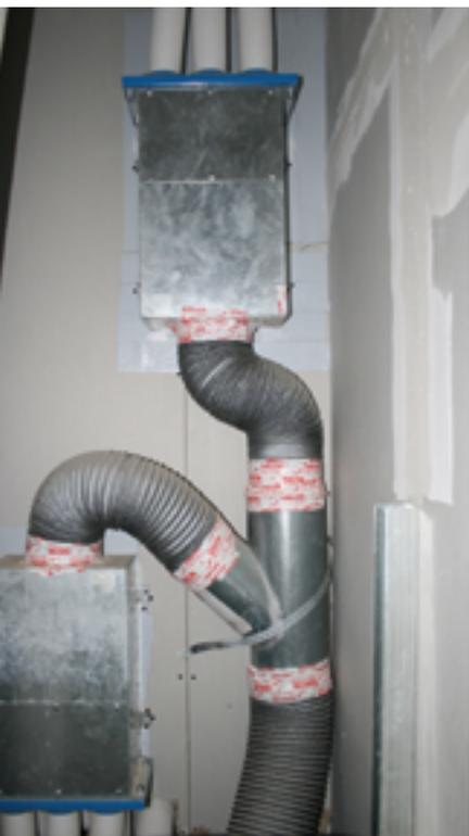
In un edificio passivo, normalmente dotato di un impianto di ventilazione meccanica controllata, si adotta un tasso di ricambio dell'aria pari a  $0,4 \text{ h}^{-1}$ , valore ritenuto compatibile sia con le esigenze di risparmio energetico sia con quelle di qualità ambientale.
