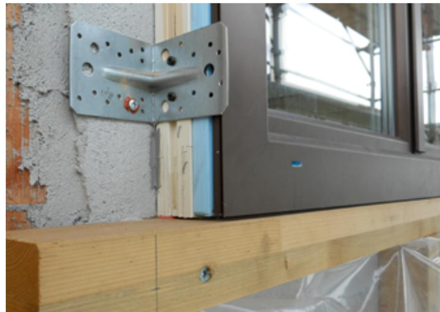
Particolare della posa del serramento sul piano del primo strato di isolante, in assenza di falso telaio.
