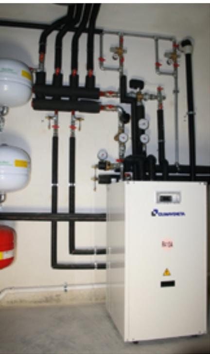
Tale condizione permette di massimizzare il rendimento termico del generatore; in quanto, la temperatura massima di produzione dell'acqua calda per il riscaldamento è di 35 – 38 °C e la macchina funziona fra il 40 e il 50% della sua potenza, punto di lavoro a massimo rendimento (COP anche superiori a 4).
