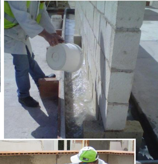
2...Costruzione di un muro in tufo
