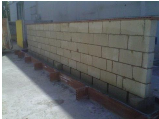
4...Comparsa di umido ed efflorescenze saline
