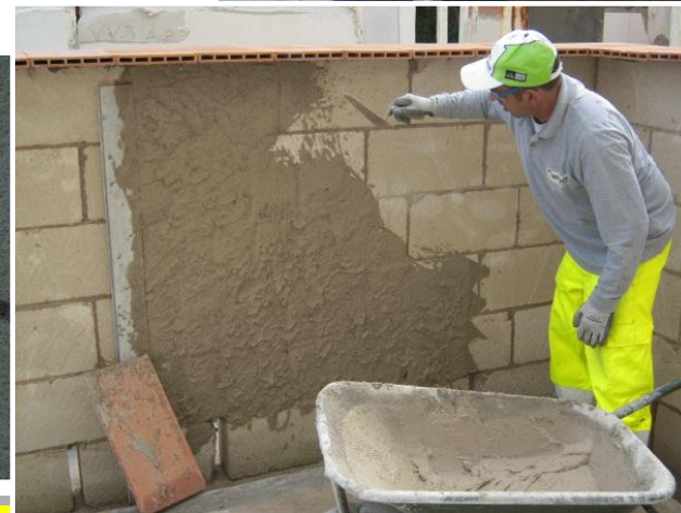
5...Realizzazione di specchiature di intonaci da risanamento
